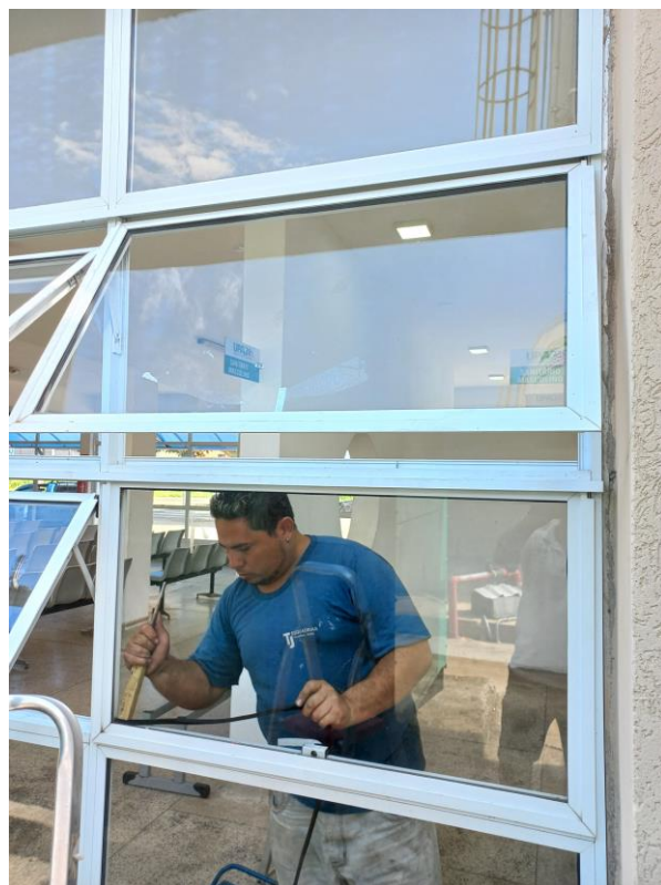
25/01 – Substituição braços basculante danificados de 02 janelas recepção próximo ao gerador
