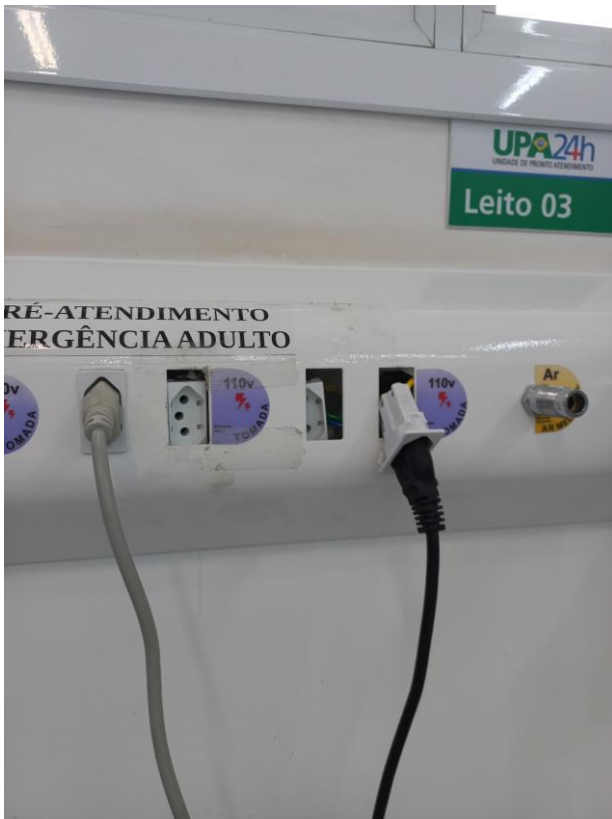
04/01 – Substituição 03 módulos de tomada leito 3 emergência
