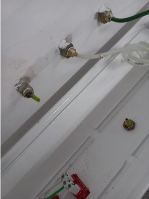
16/01 – Substituição mangueira ressecada ar comprimido leito 2 observação
