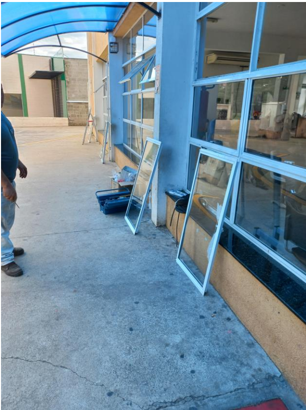
24/01 – Substituição braços basculante danificados de 05 janelas frente da UPA
