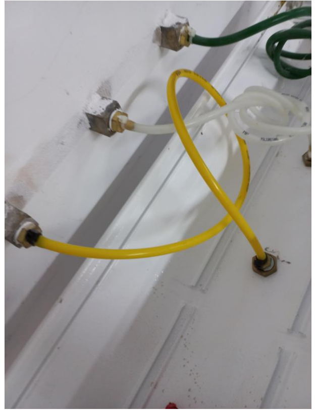
16/01 – Substituição mangueira ressecada ar comprimido leito 2 observação
