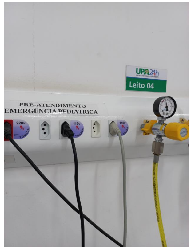
05/01 – Substituição de 01 modulo de tomada leito 04 emergência.
