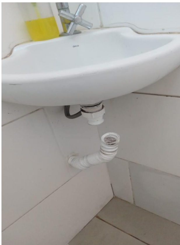
25/01 – Substituição sifão danificado banheiro da emergência
