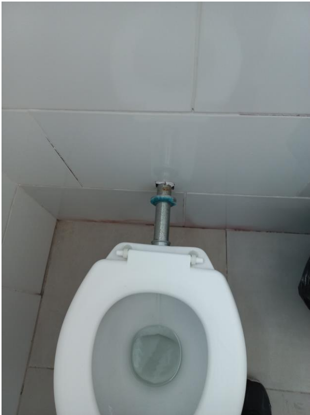
16/01 – Substituição conjunto de ligação ajustável com vazamento sala de descompressão
