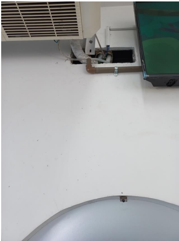
05/01 – Instalação de tubo PVC para drenagem de ar condicionado espera infantil
