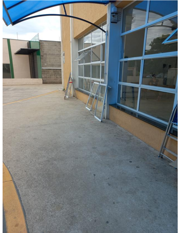
24/01 – Substituição braços basculante danificados de 05 janelas frente da UPA
