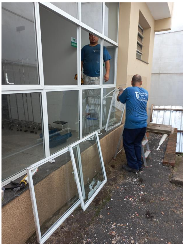
25/01 – Substituição braços basculante danificados de 04 janelas isolamento feminino
