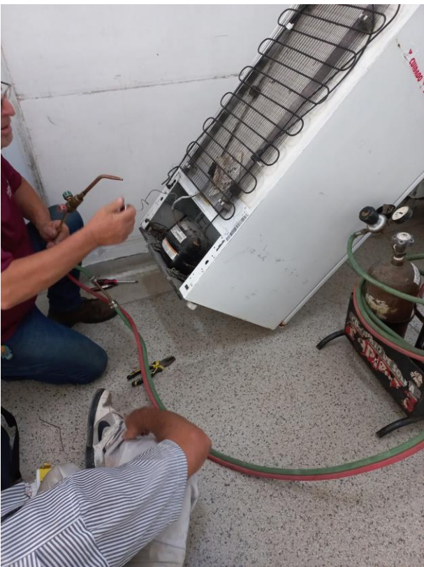
16/01 – Substituição de motor queimado e conserto geladeira repouso dos médicos
