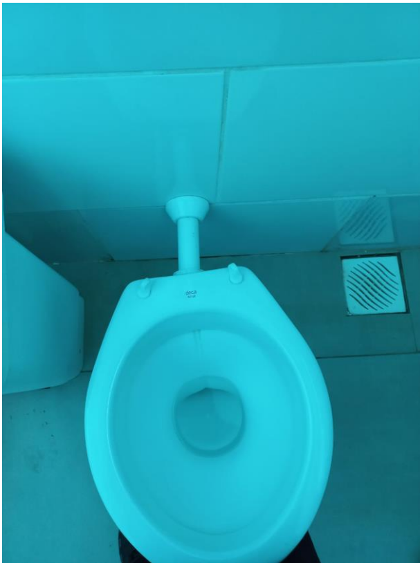
16/01 – Substituição conjunto de ligação ajustável com vazamento banheiro emergência
