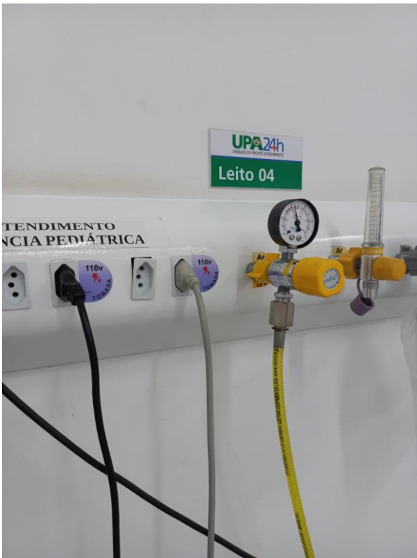
05/01 – Substituição de 01 modulo de tomada leito 04 emergência.
