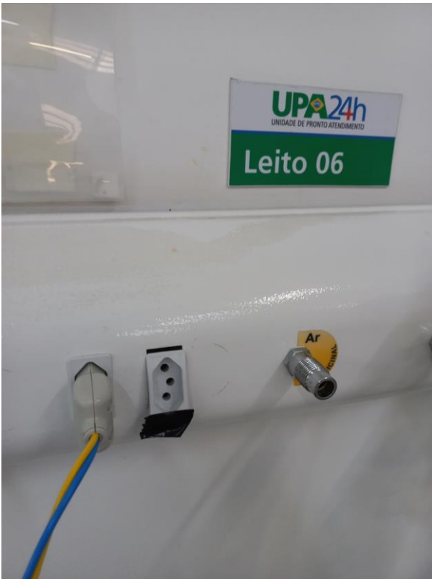
05/01 – Substituição de 01 modulo de tomada leito 6 emergência
