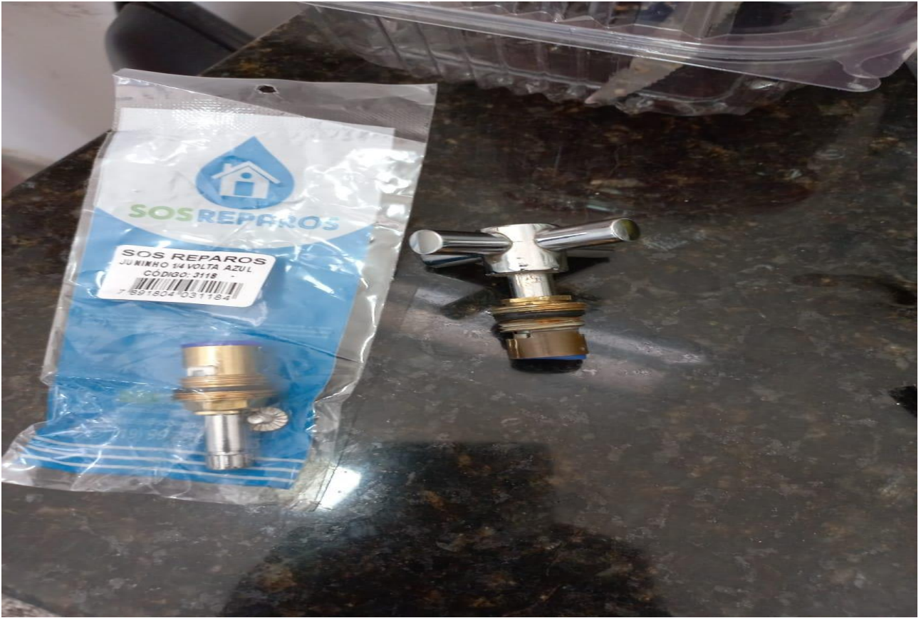
18/01- Realizado troca de reparo torneira pia interna recepção
