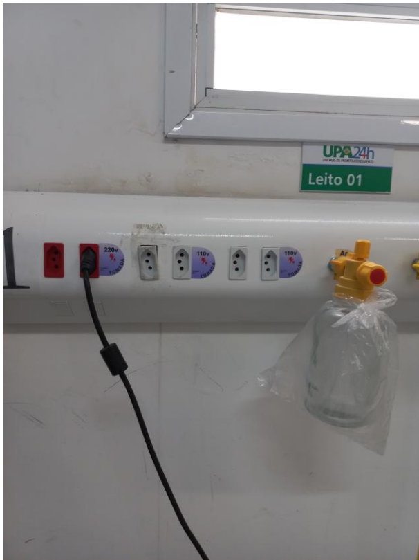
04/01 – Substituição 2 módulos de tomada leito 1 emergência
