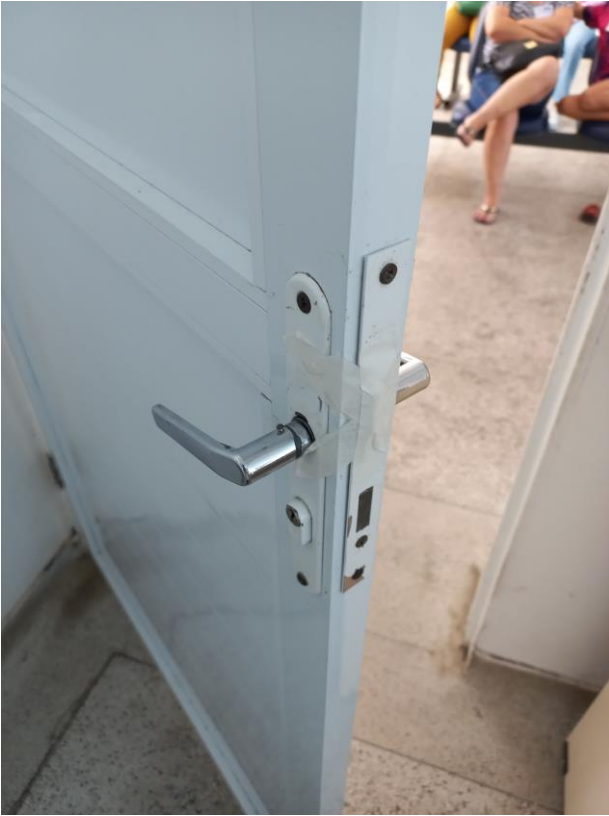
24/01 – Substituição fechadura danificada recepção
