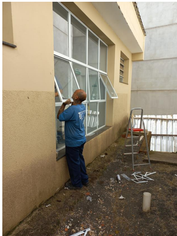
25/01 – Substituição braços basculante danificados de 04 janelas isolamento feminino
