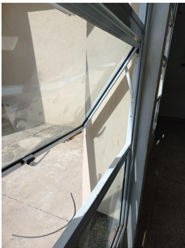
25/01 – Substituição braços basculante danificados de 02 janelas recepção próximo ao gerador
